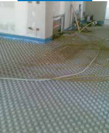
Montarea sistemului de incalzire prin pardoseala
