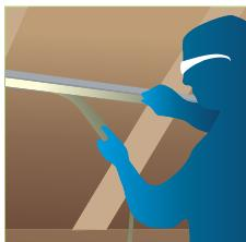
După montajul vatei minerale între căpriori, instalați profilele metalice pe bridlele de suspendare, iar apoi aplicați peste aceste profile banda dublu-adezivă Homeseal LDS Solifit-2.
