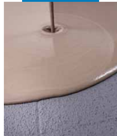
Aplicarea șapei autonivelante Ultraplan pe Eco Prim Grip uscat, aplicat în prealabil pe pardoseala existentă
