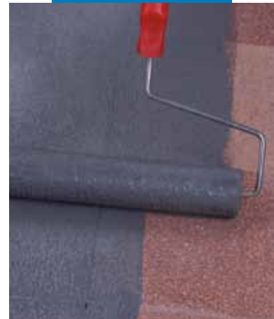
Aplicarea de Eco Prim Grip pe o pardoseală din dale terazzo, cu trafalet
