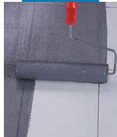
Aplicarea de Eco Prim Grip pe o pardoseală din plăci de gresie porțelanată, cu trafalet
