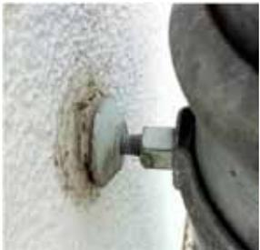
Hier wurde der Dübel zu tief in die Dämmung gedrückt und das Loch „ausgeschmiert“
